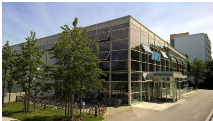
Sporthalle SVN München Multifunktionshalle mit Kletterhalle & Boulderzentrum
